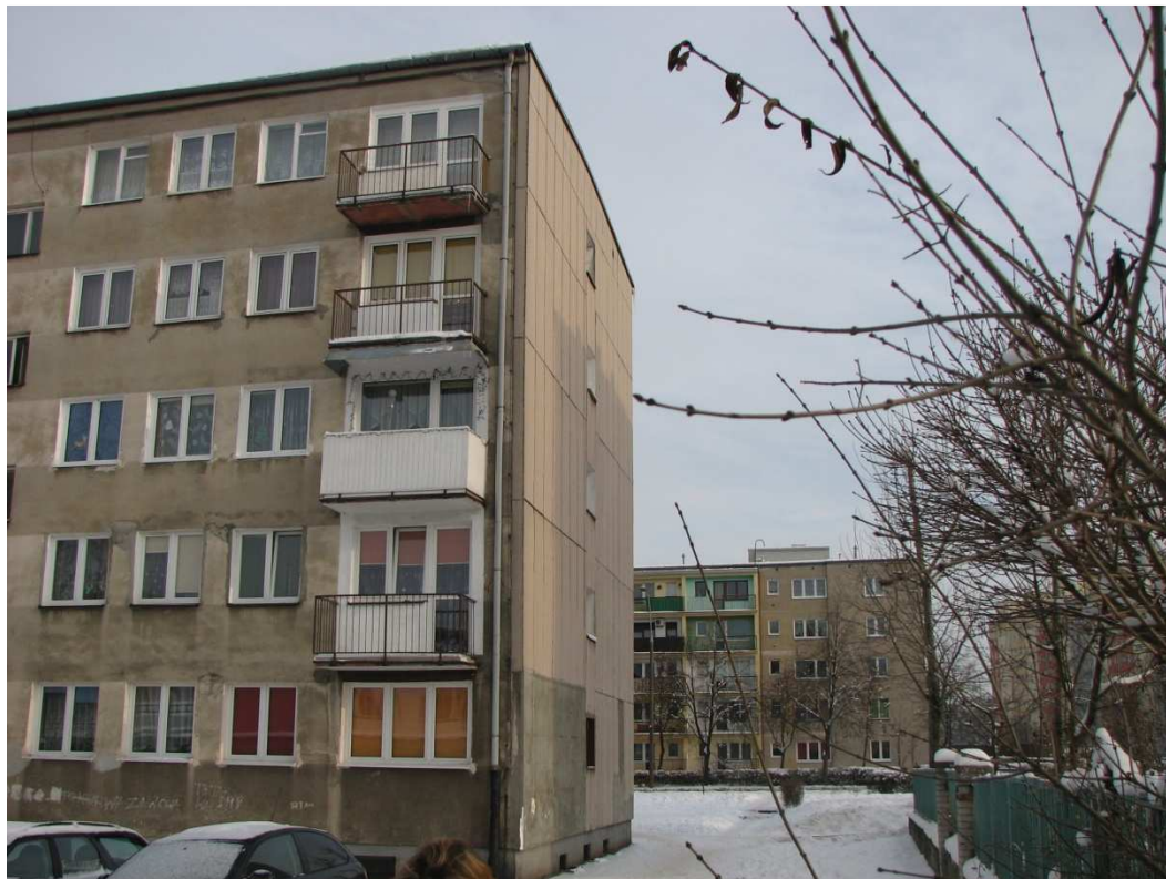
Fot. 2. Elewacja południowa (boczna).
