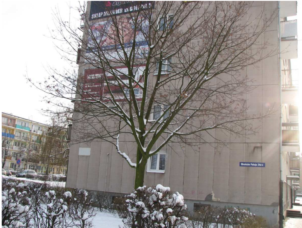
Fot. 1. Elewacja północna (boczna).
