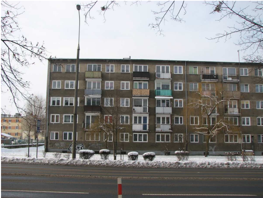
Fot. 3. Elewacja wschodnia (tylna).
