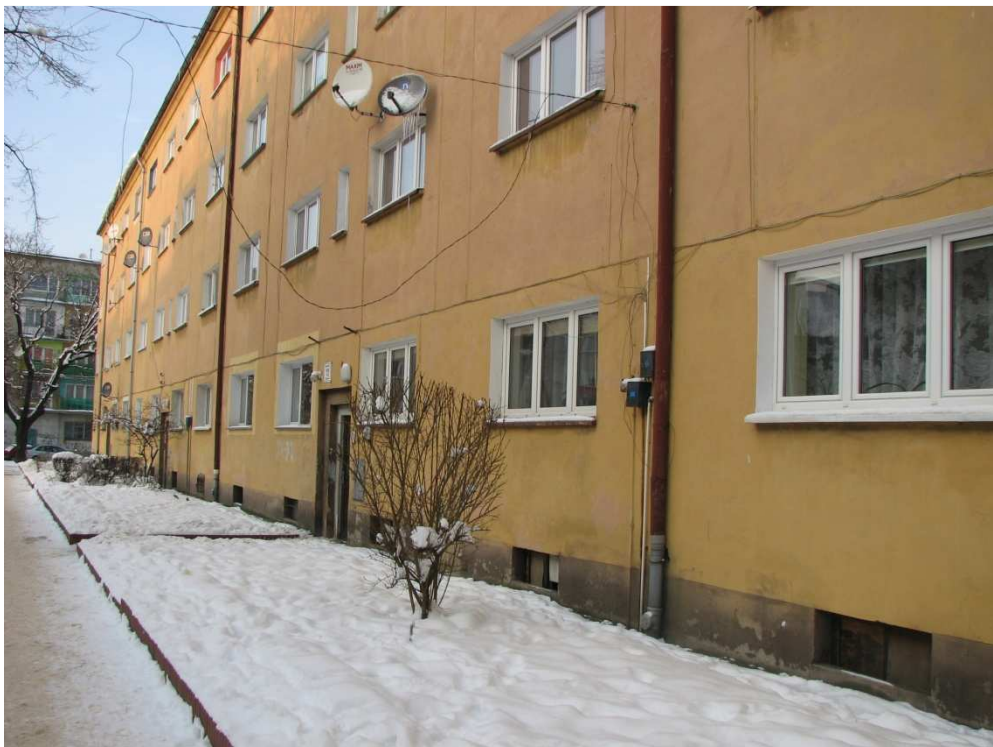
Fot. 4. Elewacja południowo-zachodnia (frontowa).
