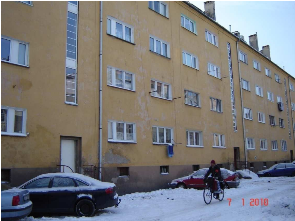
Fot. 3. Elewacja północno-wschodnia (tylna).
