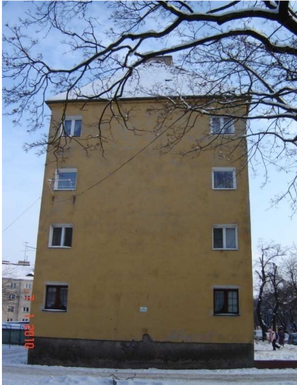
Fot. 1. Elewacja północno-zachodnia (boczna).
